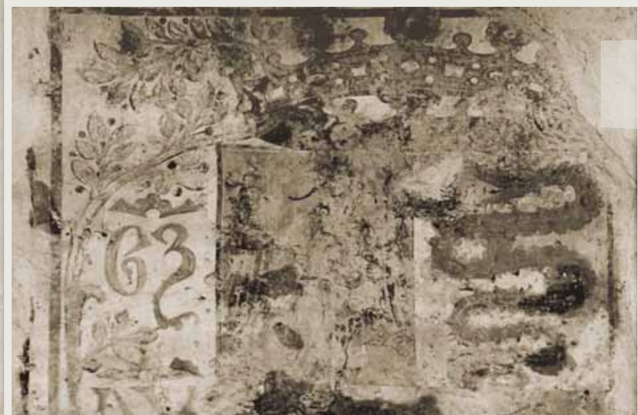
Stemma Sforzesco ancora visibile in centro paese
