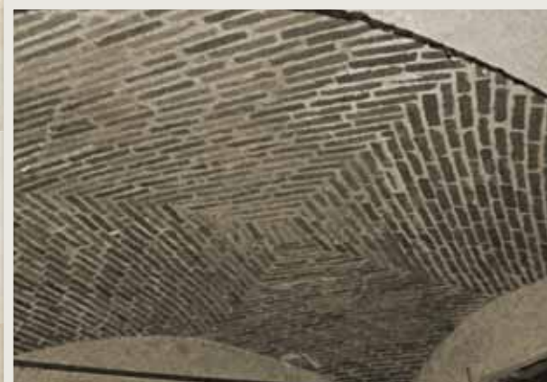
Soffitto di vecchia cantina in via Roma
