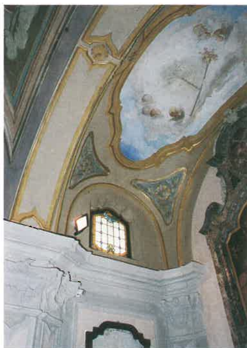
26, 27 - La volta della cappella della Beata Vergine del Buon Consiglio prima e dopo i restauri.
