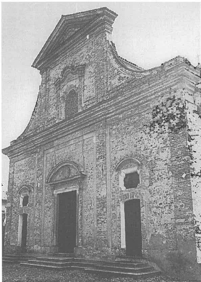
10 - La facciata della chiesa.
